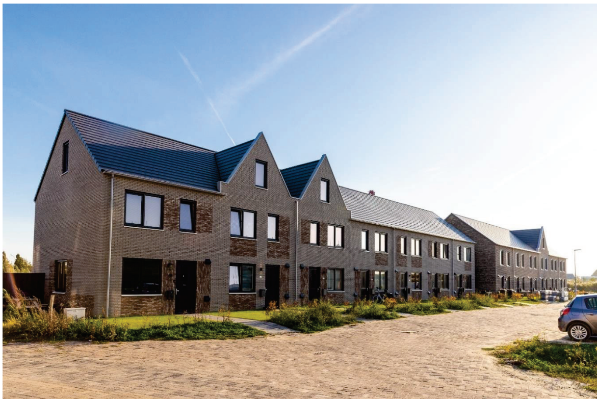
20 ééngeswoningen Olmenkwartier (Warande)
