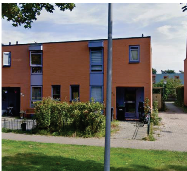
Herbouwde brandwoning Wold 23-11
