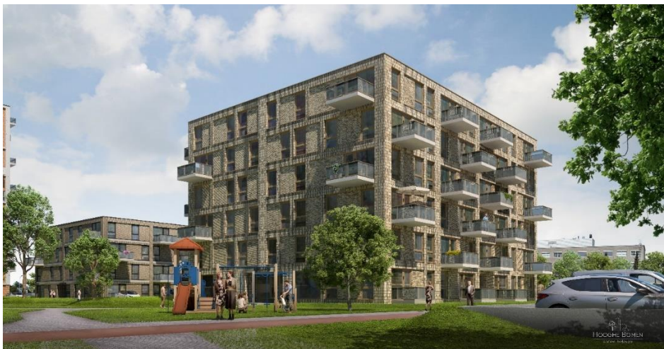
43 appartementen Hooghe Bomen gebouw D 'Espelbach'
