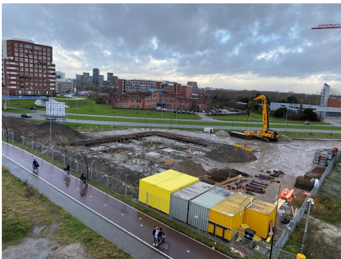
Coninxpoort de bouwput met damwand en heipalen
