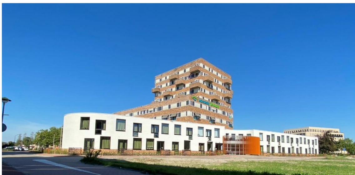
Nieuwbouw Hanzeborg zijde station
