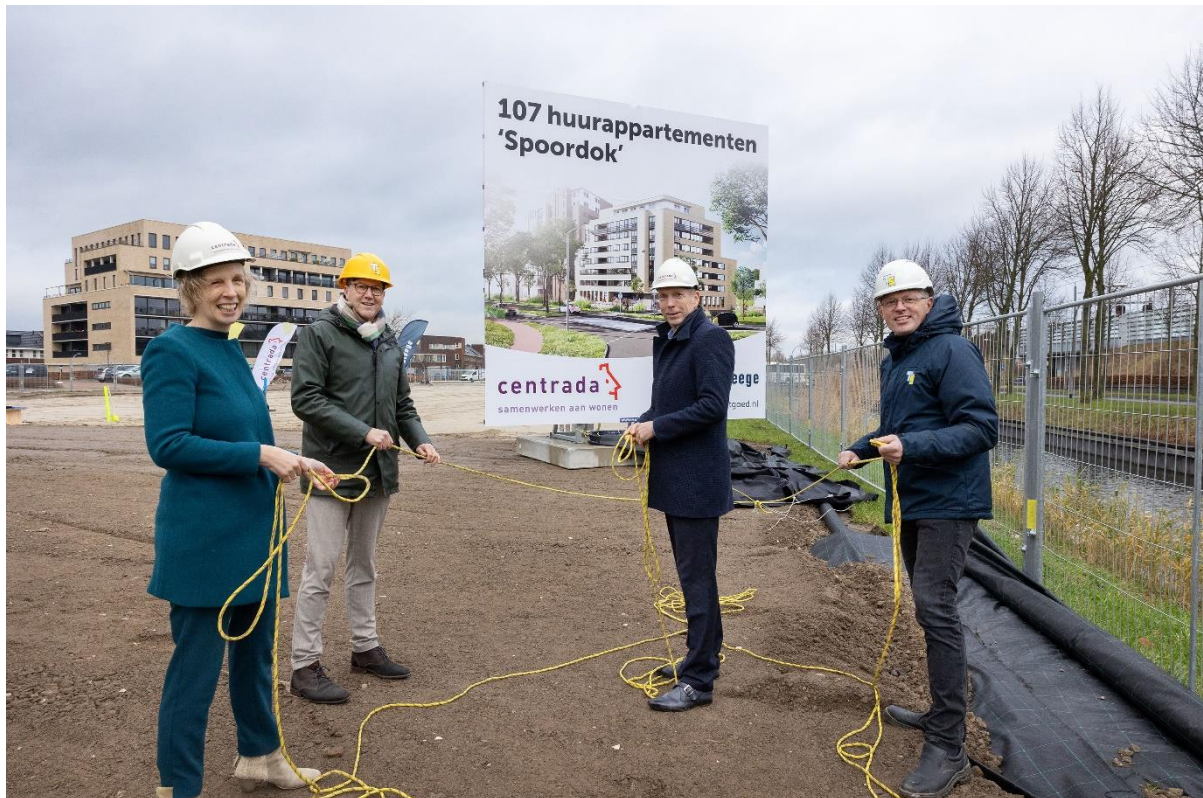
Start bouw 107 appartementen Spoordok nabij het station
